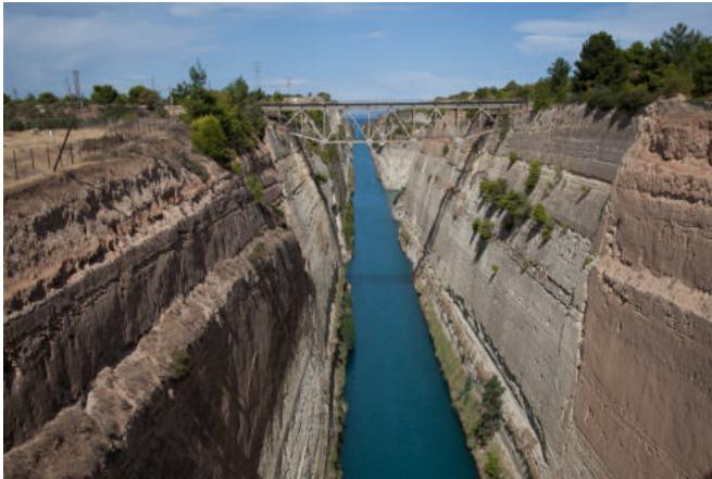
der Kanal von Korinth
